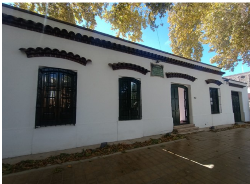
Figura 2. Fachada de la Biblioteca Infantil Provincial Juan Pablo Echagüe, ubicada en la calle 25 de mayo 463 oeste, San Juan. Registro fotográfico propio, realizado el día 30 de abril de 2024.
